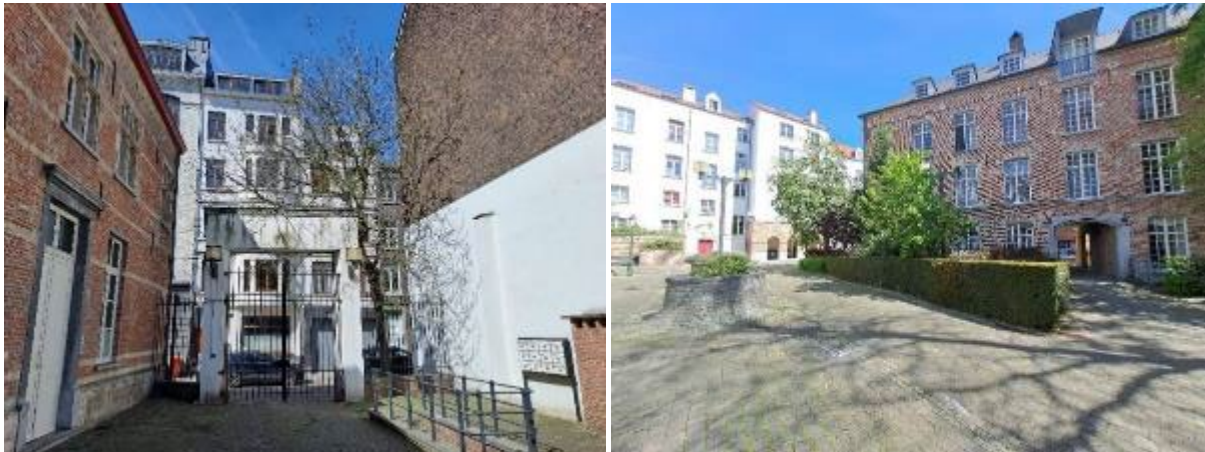
Accès fermé à clé de la zone de servitude et aménagement de la zone en espace d'agrément
