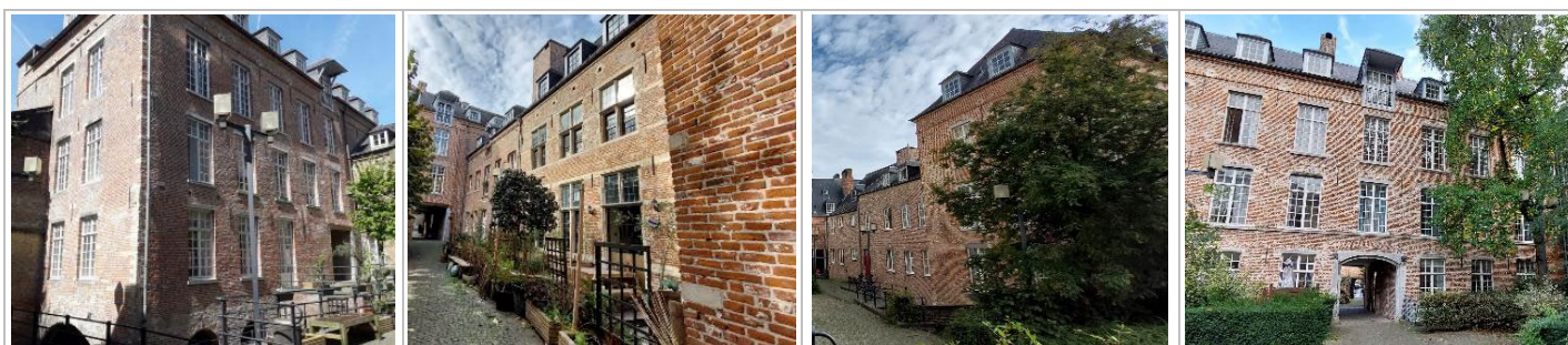
Bâtiment d'intérieur d'îlot, rue Saint Christophe n°34 : orientation est (à gauche), orientation sud (à droite)
