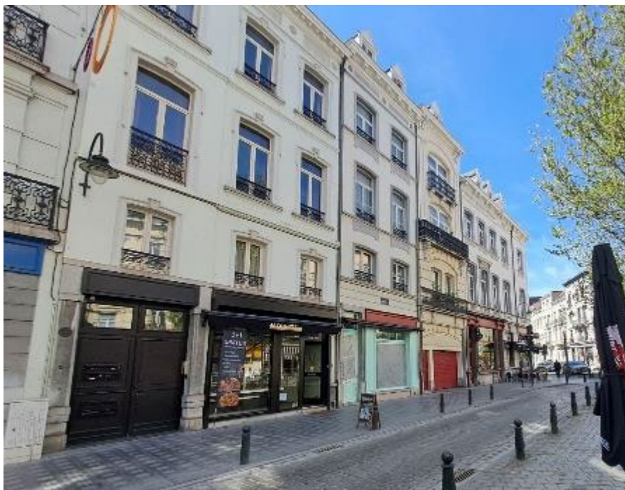
Ecartis aux prescriptions du PPAS : commerces et châssis des rez de chaussée (rue Pletinckx)
