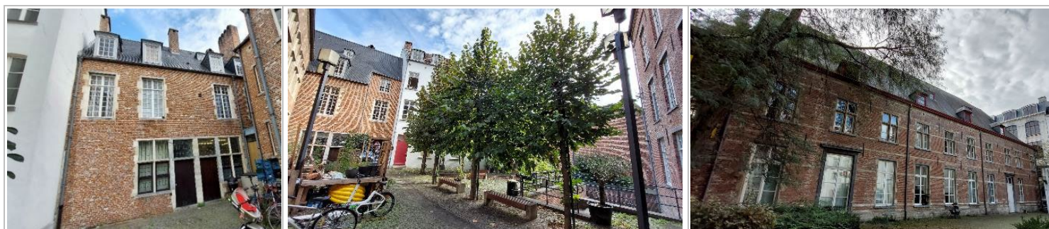
Bâtiments d'intérieur d'îlot : façade arrière, rue de la Grande-île 20-21 (à gauche), façade arrière, place Saint-Géry 23-rue de la Grande-île 1-9 (à droite)
